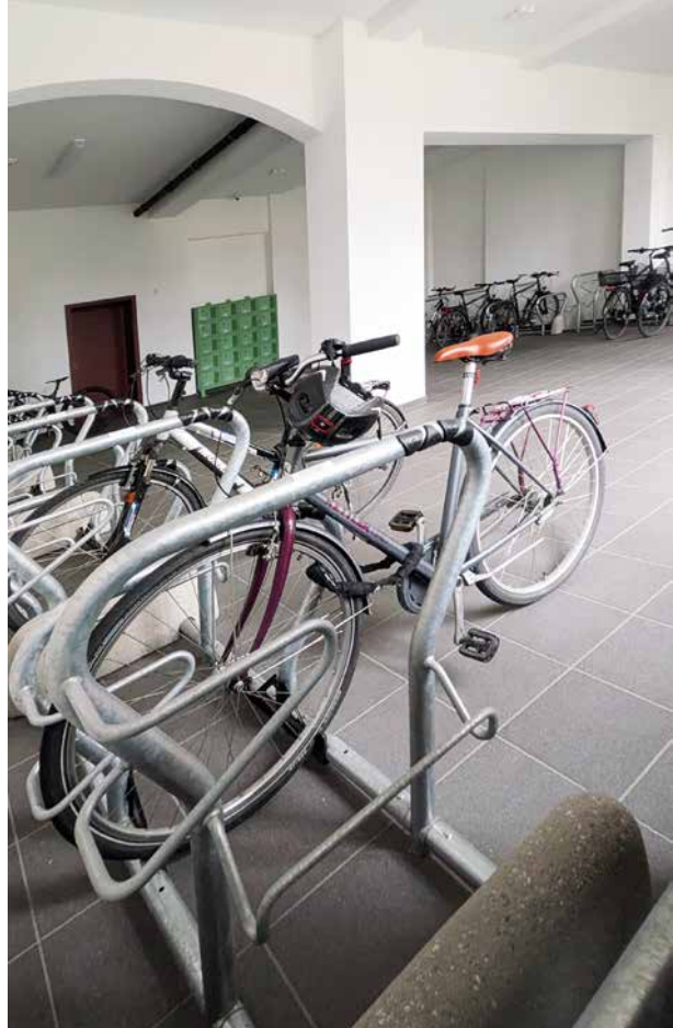
AUFGRUND DER GROßEN NACHFRAGE MUSSTE DAS FAHRRADPARKHAUS 2019 ERWEITERT WERDEN. IM BILD DER ZWEITE BAUABSCHNITT.
